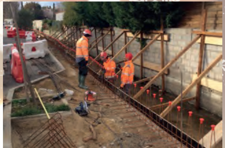
DECEMBRE : début des travaux rue du ruisseau
