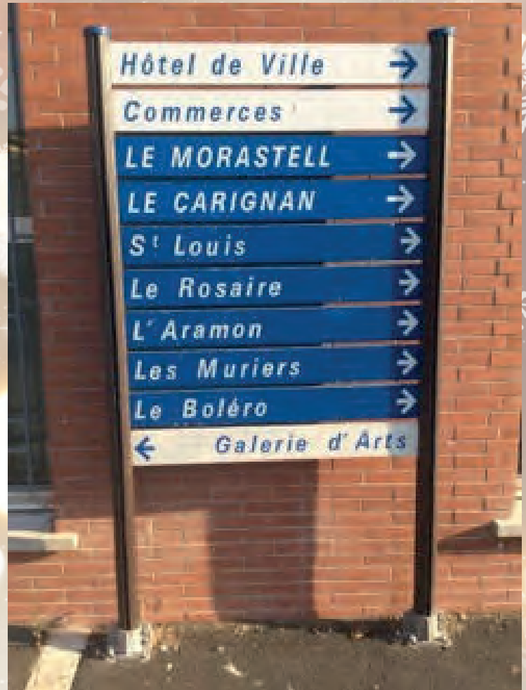
AOÛT : installation de panneaux directionnels
