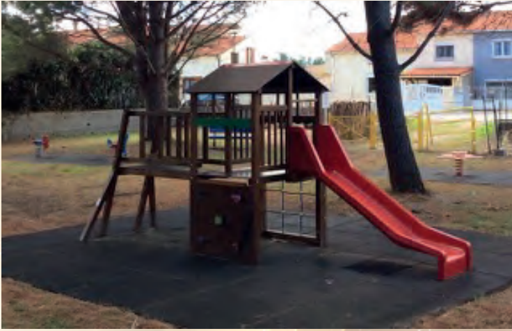
OCTOBRE : travaux d'entretien à l'aire de jeux
